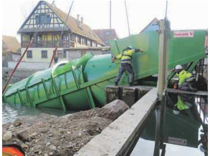
Mise en place de la troisième turbine hydroélectrique sur l'Ill, à Muttersholtz (Alsace), le 6 février 2019.
